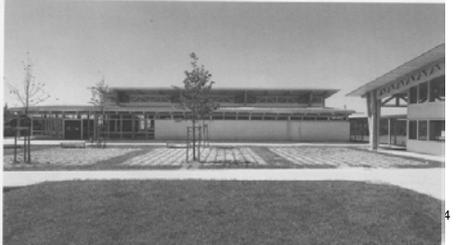
**1** La structure en lamibois est découpée des poteaux en béton armé par une étroite bande vitrée.
