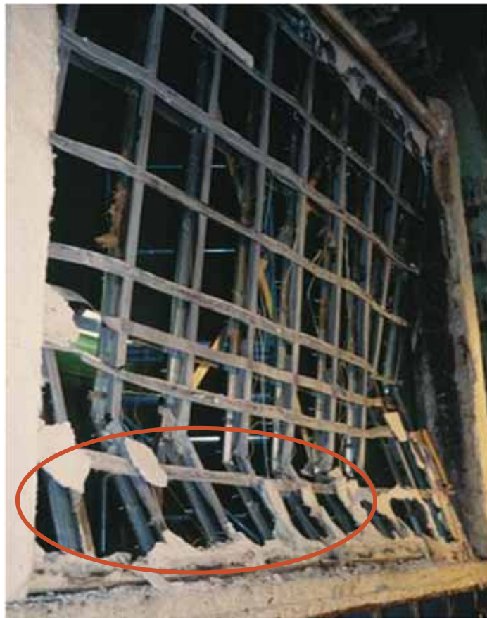
L'ossature acier a perdu son rôle de structure
