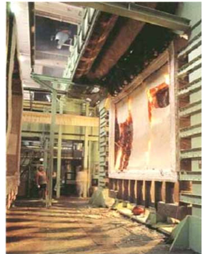
L'ossature bois conserve son rôle de structure
